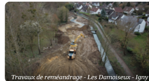
Travaux de reméandrage - Les Damoiseux - Igny
